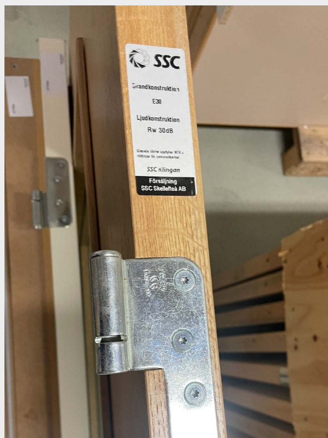
Exempel på klisteretikett på dörrblad som anger brandklass av äldre standard men godkänd ljudklass.
