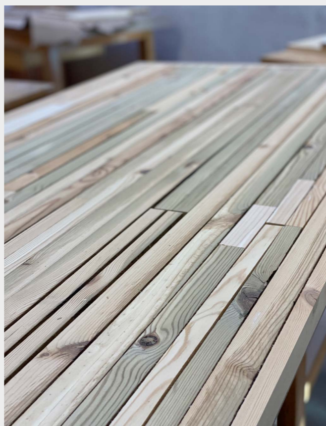
Wow, vilken överraskning - dörrbladen är uppbyggda av spillbitar av massivt trä!
