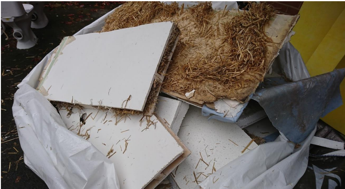
Figur 4 Delar av en riven våtrumsvägg bestående av gipsskivor, träull, träreglar, plastmatta och våtrumstapet.
