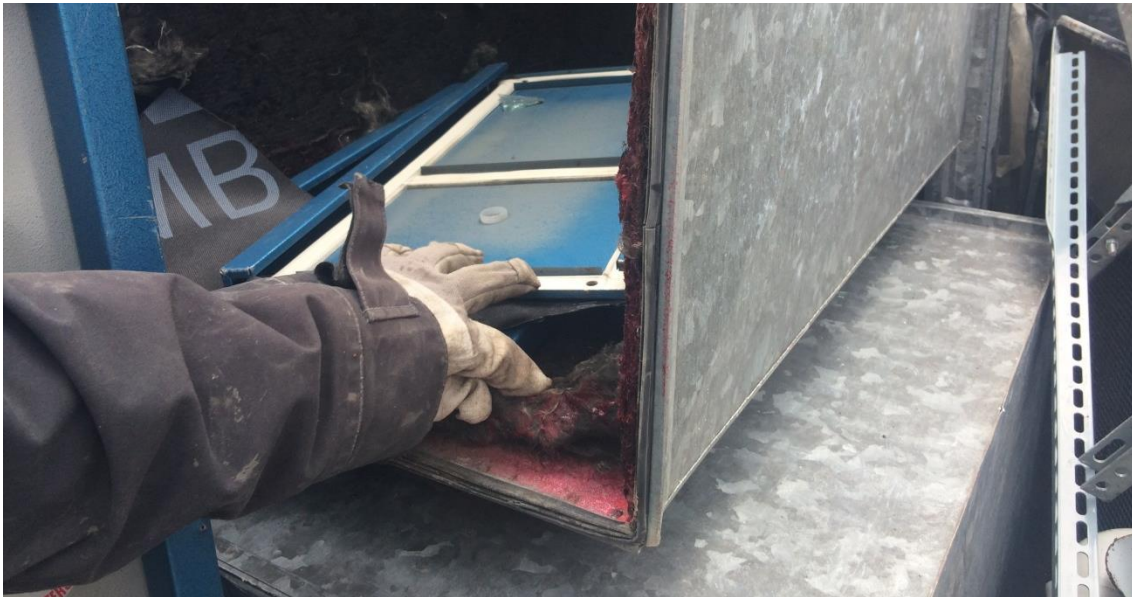
Figur 5 Limmad isolering på insidan av ventilationskanal, exempel på hur materialet eller produkten redan i sin utformning försvårar rena fraktioner
