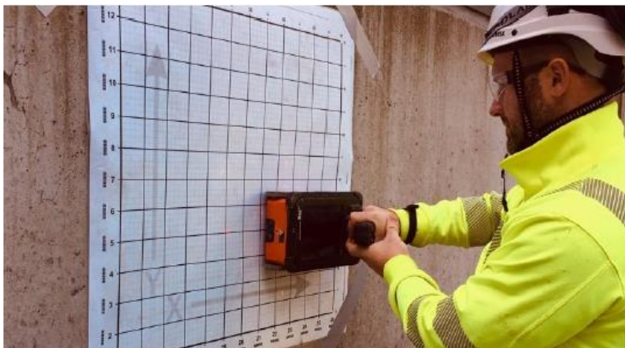
Figur 8 Användning av georadar. Källa: Underhållsplan för vattenverkets betongkonstruktioner .
