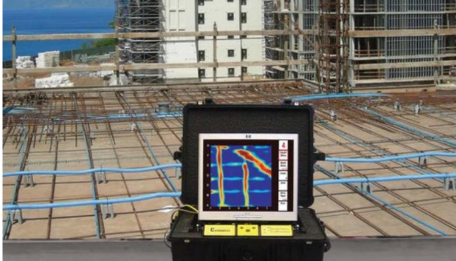
Figur 9 Exempel på hur resultat från mätning med georadar kan se ut. På datorskärmen syns armeringens och elektriska ledningars läge i betong, i bakgrunden armering och dragna ledningar innan gjutning. Källa: http://georadar.priv.no/tjenester/betongkontroll.html .
