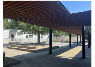
Regnskydd i korrugerad plåt som binder ihop huvudbyggnaden med matsalsbyggnaden. I bakgrunden uppväxta skuggande träd. Kan dessa tas med och flyttas?
