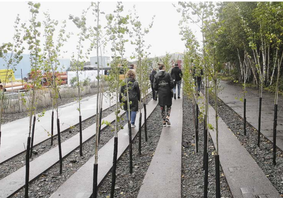
I Shoreline park i Göteborg skars det ut planteringsbäddar i asfalten och växter som klarar en växtmiljö som är kompakterad och näringsfattig planterades direkt i bärlagret.
