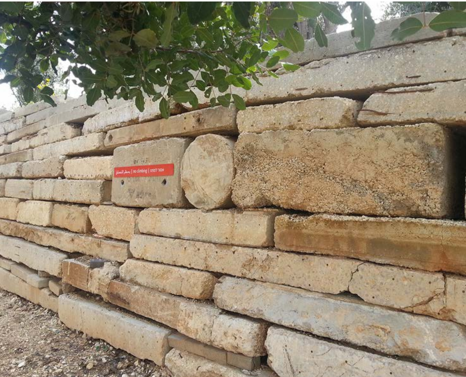
Bild tagen från Ariel Sharon park i Israel. Betongelement från rivna anläggningar har använts för att bygga upp en kallmur.
