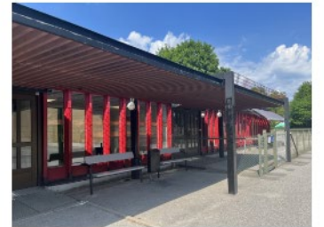
Regnskyddet i korrugerad plåt.
